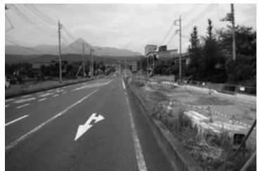
跨線橋東側の舗装工事
