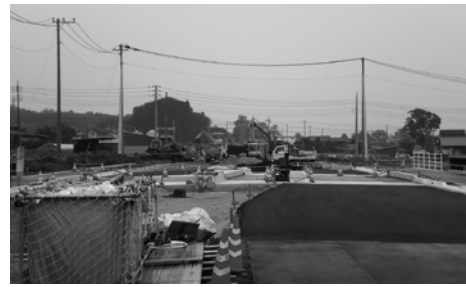
吉岡町・上野田地内の工事現場
