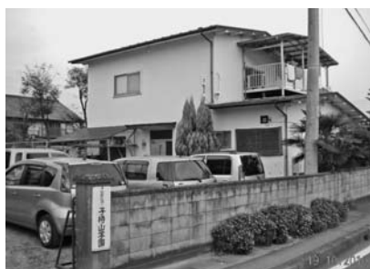
建て直される園舎別棟(子持山学園)
