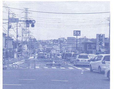
県道高渋線現道拡幅工事(石原交差点)
