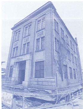
ひき家工事の様子
