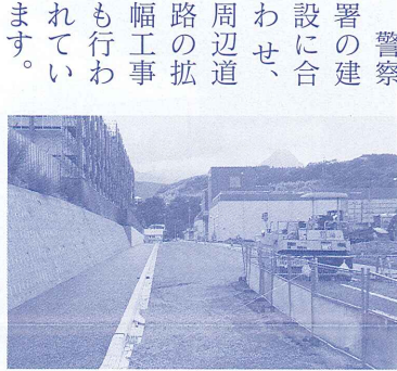
警察署北側市道の拡幅工事 正面右建物はベトナム渋川店
