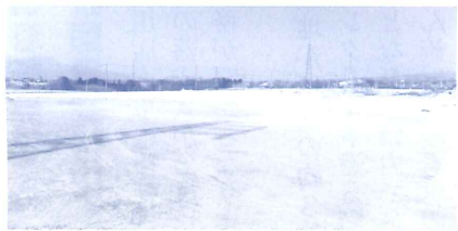
整地の進む建設地
