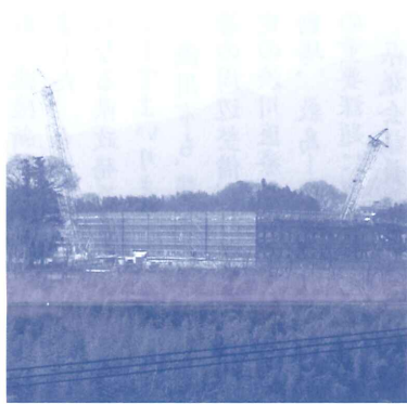
工事現場を赤城方面から見る
