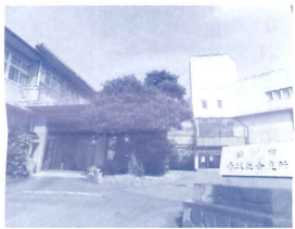
7月に解体予定の庁舎
