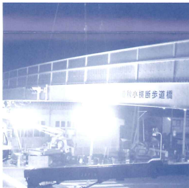
夜間の上部橋設置工事
