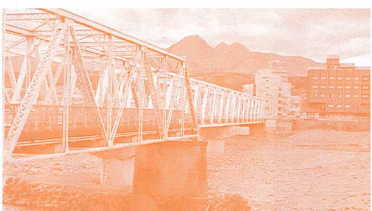
下郷側が撤去された大正橋側道橋
