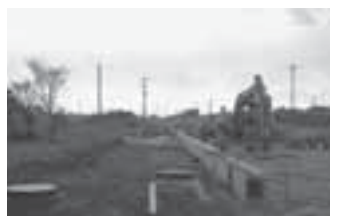
急ピッチで進む工事 吉岡町・上野田地内
