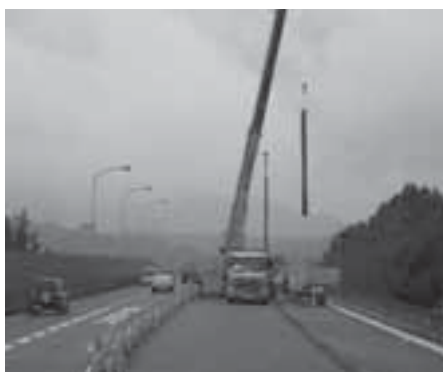
4車線化の進む中村上郷線・JR跨線橋
