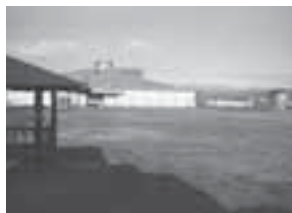
南部給食センター建設予定地(ベトナム行幸田店南有り)
