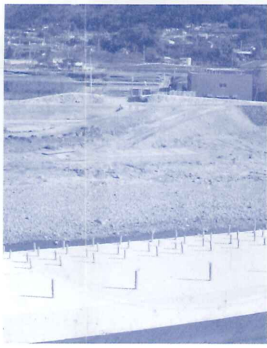
橋台工事が始まる（浅田側から見る）
