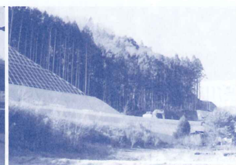
上信自動車道・祖母島バイパス
